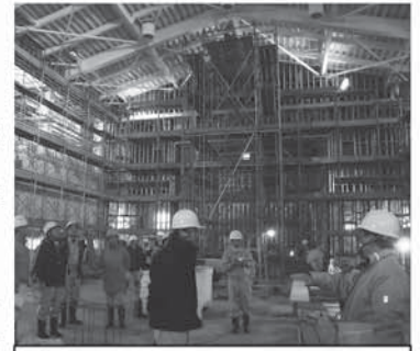
建築中の五十沢小体育館
